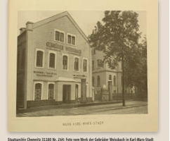
Staatshand Chemnitz 21330 Nr. 204 Foto vom Werk der Gebrüder Weißbach in Karl-Marx-Stadt
